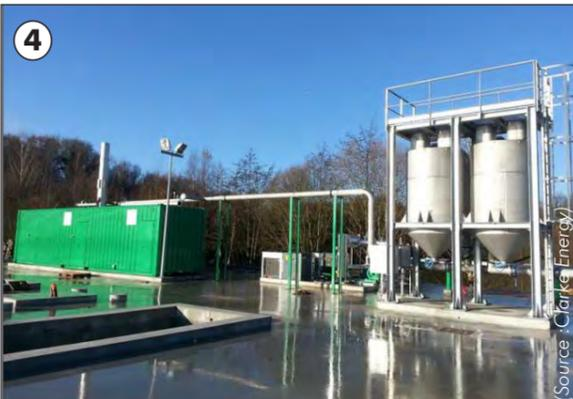
Exemple d'un digesteur et d'un gazomètre
